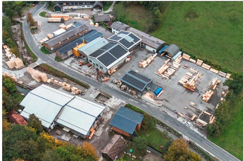
Nutzung von selbst erzeugtem Strom aus Sonnenenergie am Standort Ramsau (Österreich)
